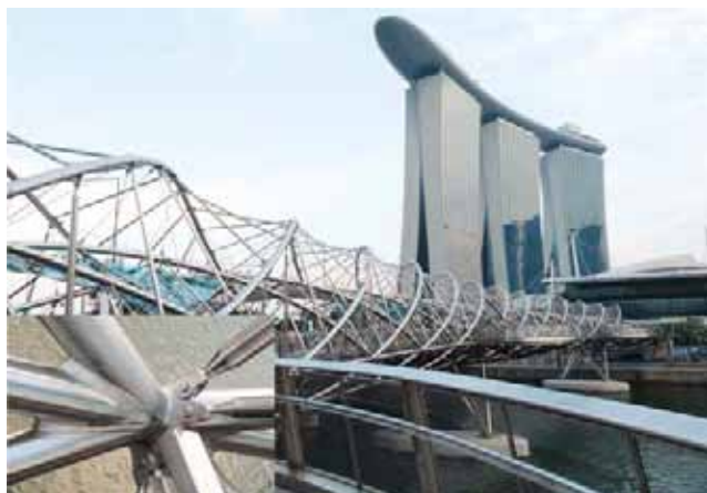
Rys. 1. Most ze stali nierdzewnej, po lewej powiększony fragment konstrukcji, Singapur
